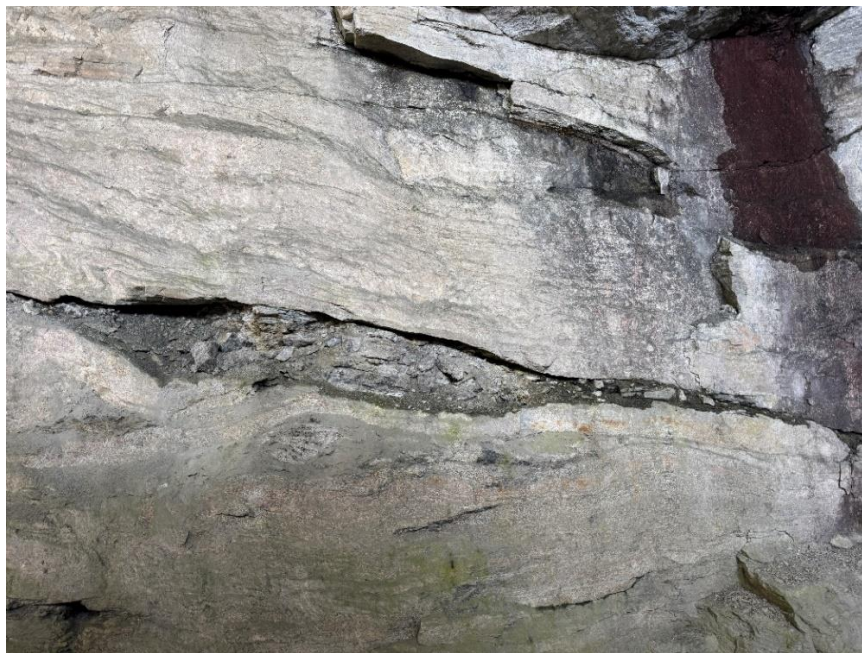
Figur 4-5: Jordfylt nær horisontal sprekk. Bilde tatt fra eksisterende bergrom.
