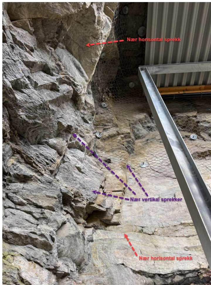
Figur 4-4: Nær vertikale og horisontale sprekker i eksisterende bergrom.
