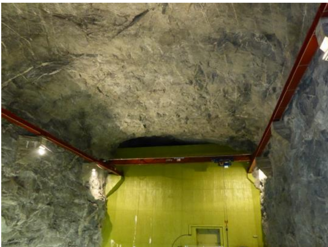
Figur 4-1: Inne i eksisterende PV1. Berghallen står fint med minimalt med bergsikring, tyder på forsiktig sprengning og god bergmassekvalitet [1].
