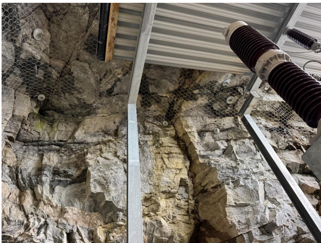
Figur 4-3: Migmatittisk gneis i Elvia sin trafohall. Bergsikring i heng med bolter og nett. Dryppsikring over trafo.
